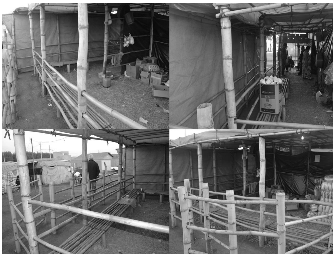
Figura 4 – Local de distribuição
